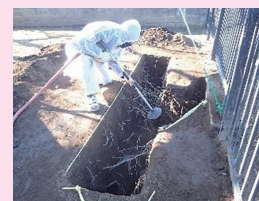
①根を傷つけないように空気圧で土を掘り下げます。
