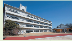
閉校した栄小学校が生まれ変わった栄市民活動交流センター
