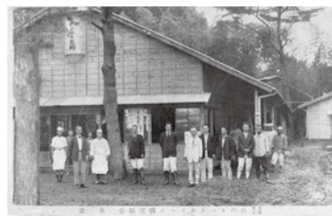
建設したトマト工場。現金の他、トマトの生果や工場作業の賃金でも出資を受け付けました。
