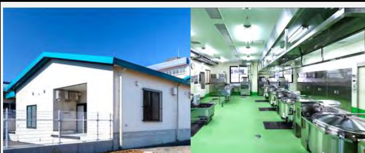
参考 東中学校給食室新築当時
