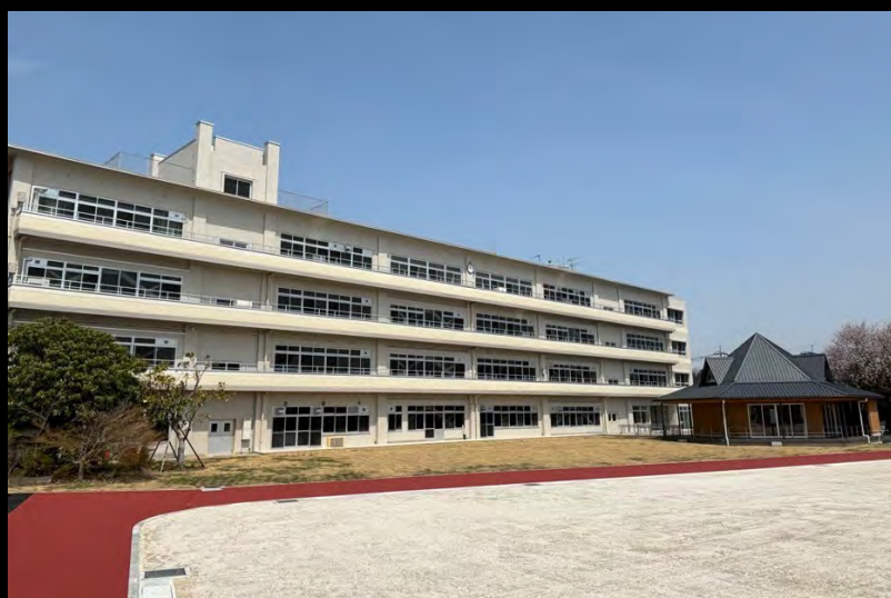
完成した栄市民活動交流センター
