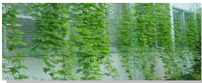
壁面緑化 市役所第 4 庁舎
