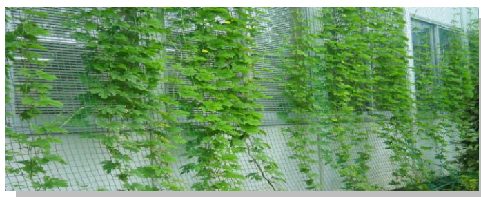
壁面緑化 市役所第 4 庁舎
