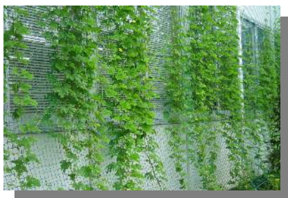
壁面緑化 市役所第4庁舎
