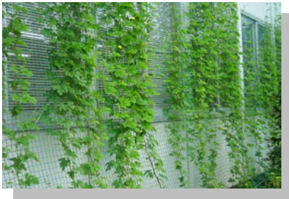
壁面緑化 市役所第4庁舎
