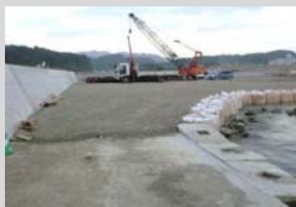
海岸堤防復旧工事
