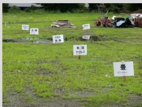
仮置場における立看板 (効率的な粗選別が可能となる) 出典) 災害廃棄物対策フォトチャンネル(環境省)
