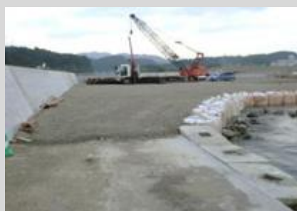
海岸堤防復旧工事
