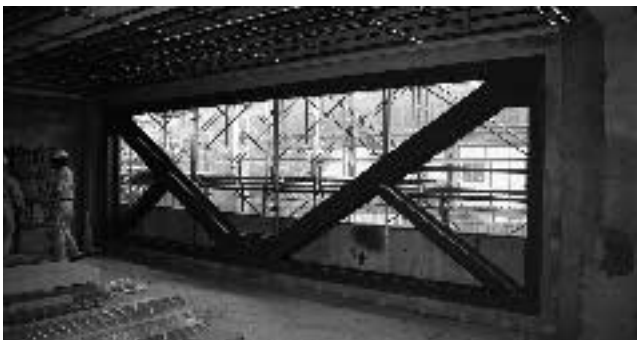
北本中学校の耐震工事の様子
