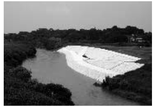
護岸工事が完了した水辺プラザ予定地
