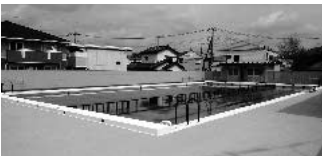
改修工事でコースが分けられた西小学校プール
