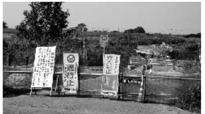
台風の影響により通行止めとなっている高尾橋
