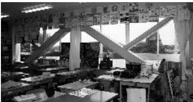
耐震化された西中学校校舎
