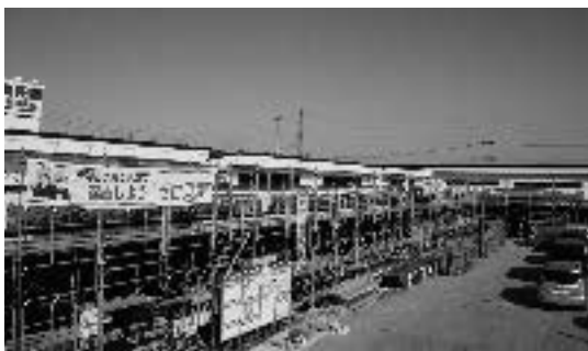
建設中の中核保育所
