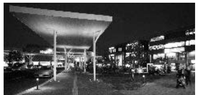
多目的広場付近の照明
