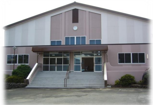
耐震化された屋内運動場
