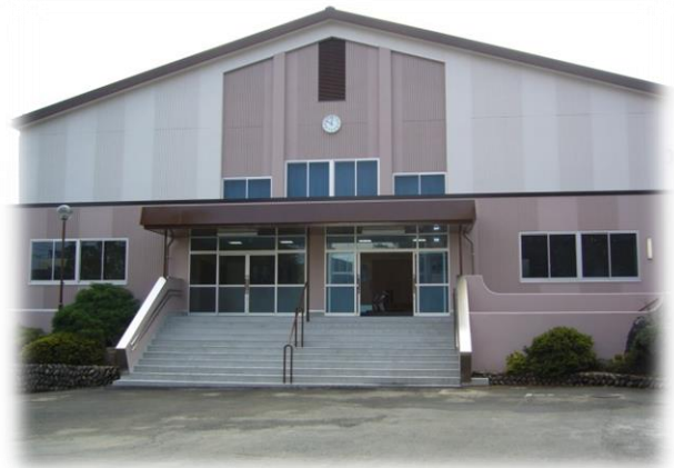
耐震化された屋内運動場
