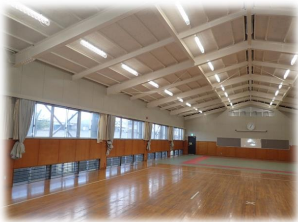
中学校武道場における天井等の 非構造部材の耐震化
