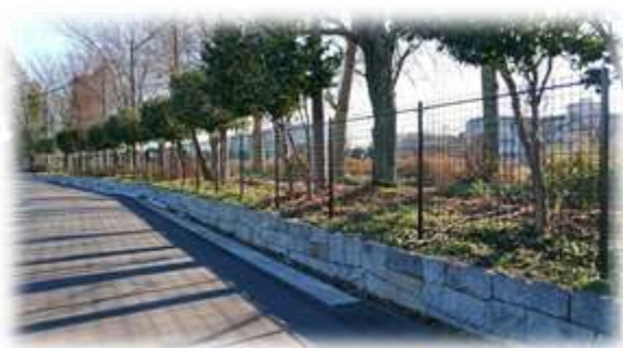
学校施設の外周防犯フェンスの設置・整備
