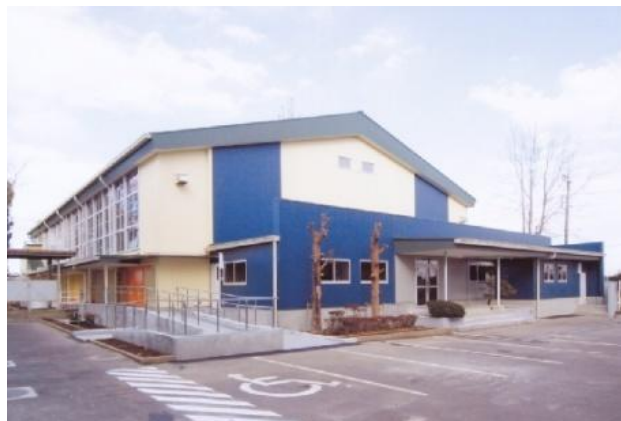
耐震工事及び大規模改修された体育館
