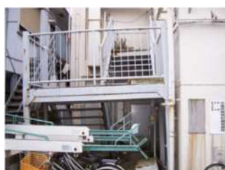
①屋外階段が傾斜
