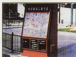
* 案内図等に利用された地上変圧器
