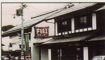
* 瓦屋根の使用
