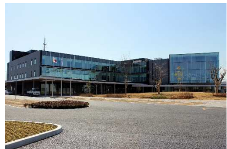
バリアフリー化された北本市役所
