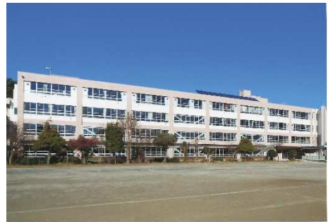
耐震化工事をした北本中学校
