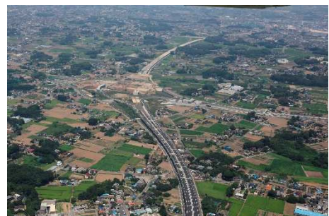
桶川北本インターチェンジ周辺 (平成 24 年 7 月撮影)
