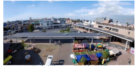
北本駅西口駅前広場
