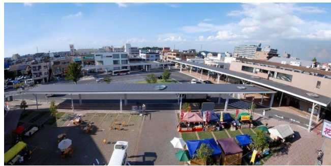
北本駅西口駅前広場
