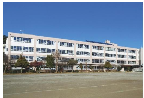
耐震化工事をした北本中学校
