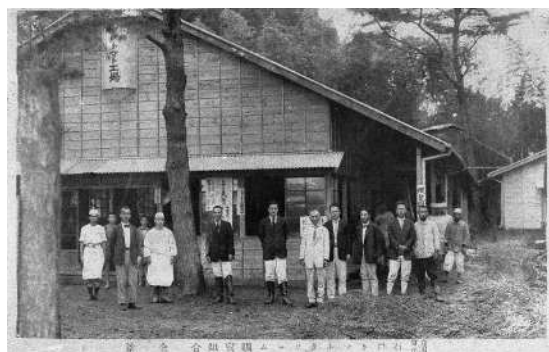
石戸トマト工場
