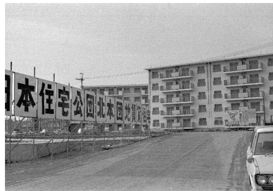
北本団地の建設(昭和46年)
