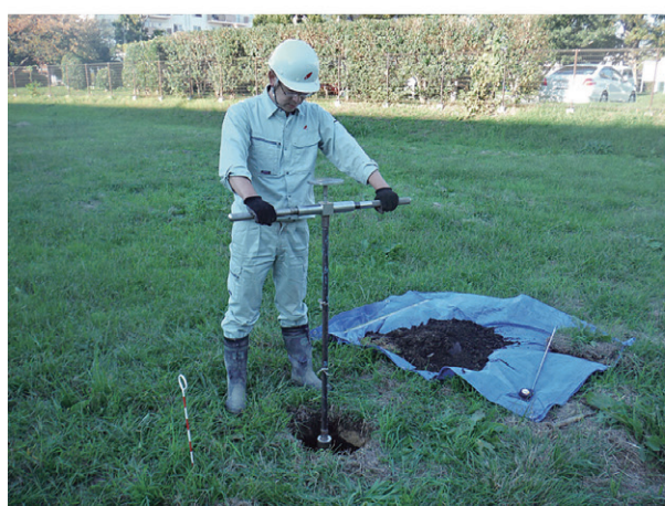
8. ボーリング作業風景(2地点)
