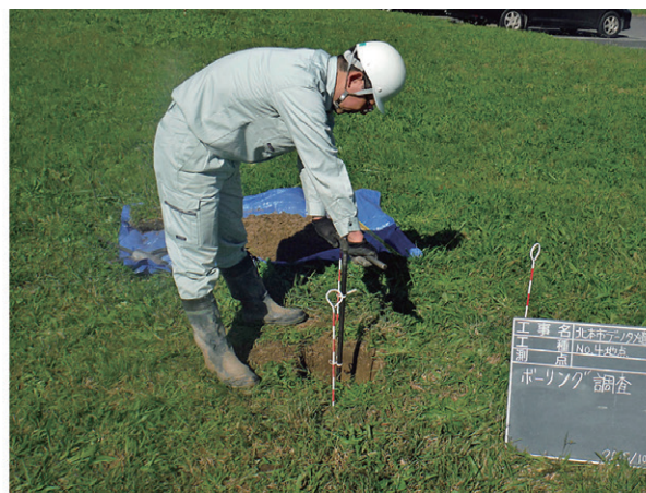
17. ボーリング作業風景(4地点)
