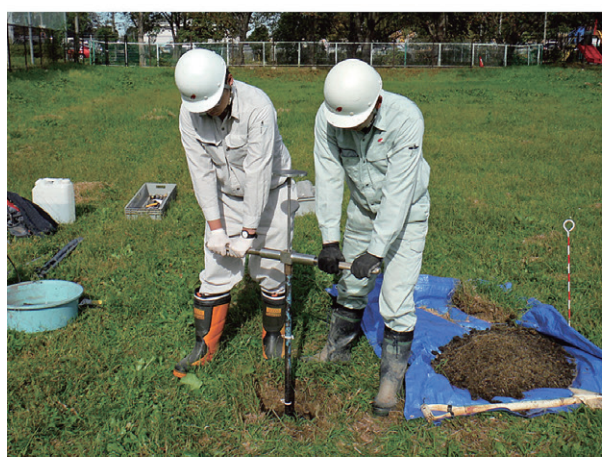
3. ボーリング作業風景(1地点)
