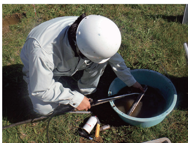
13. ボーリング作業風景(3地点)
