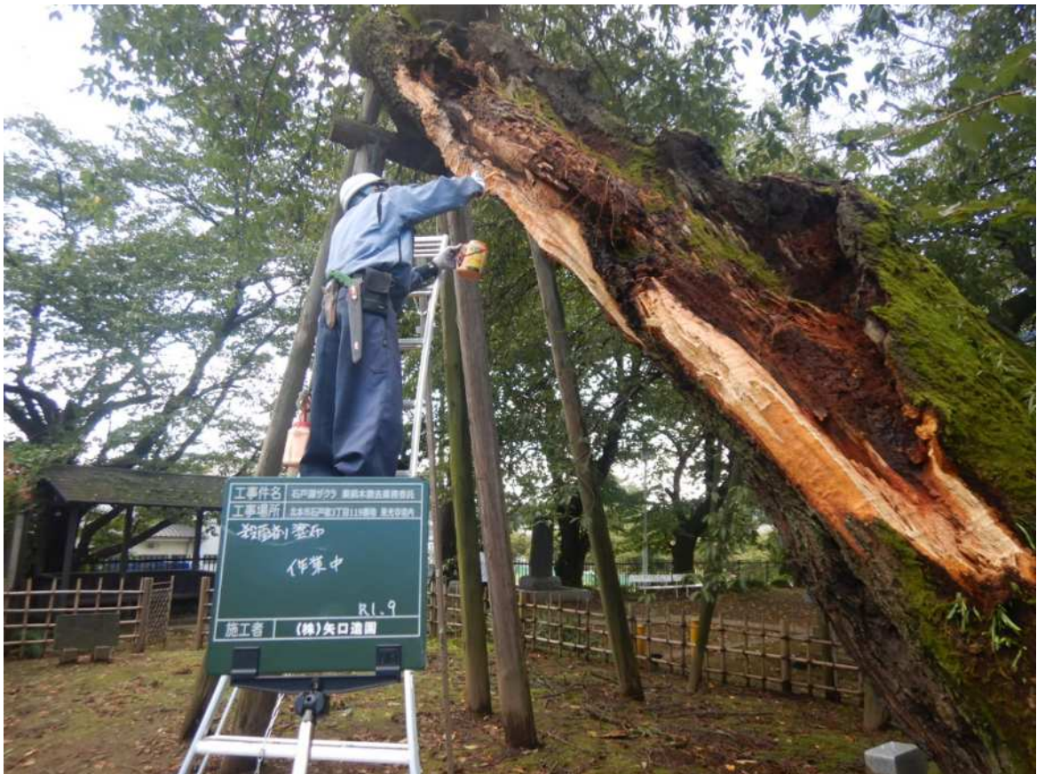
薬剤塗布作業
