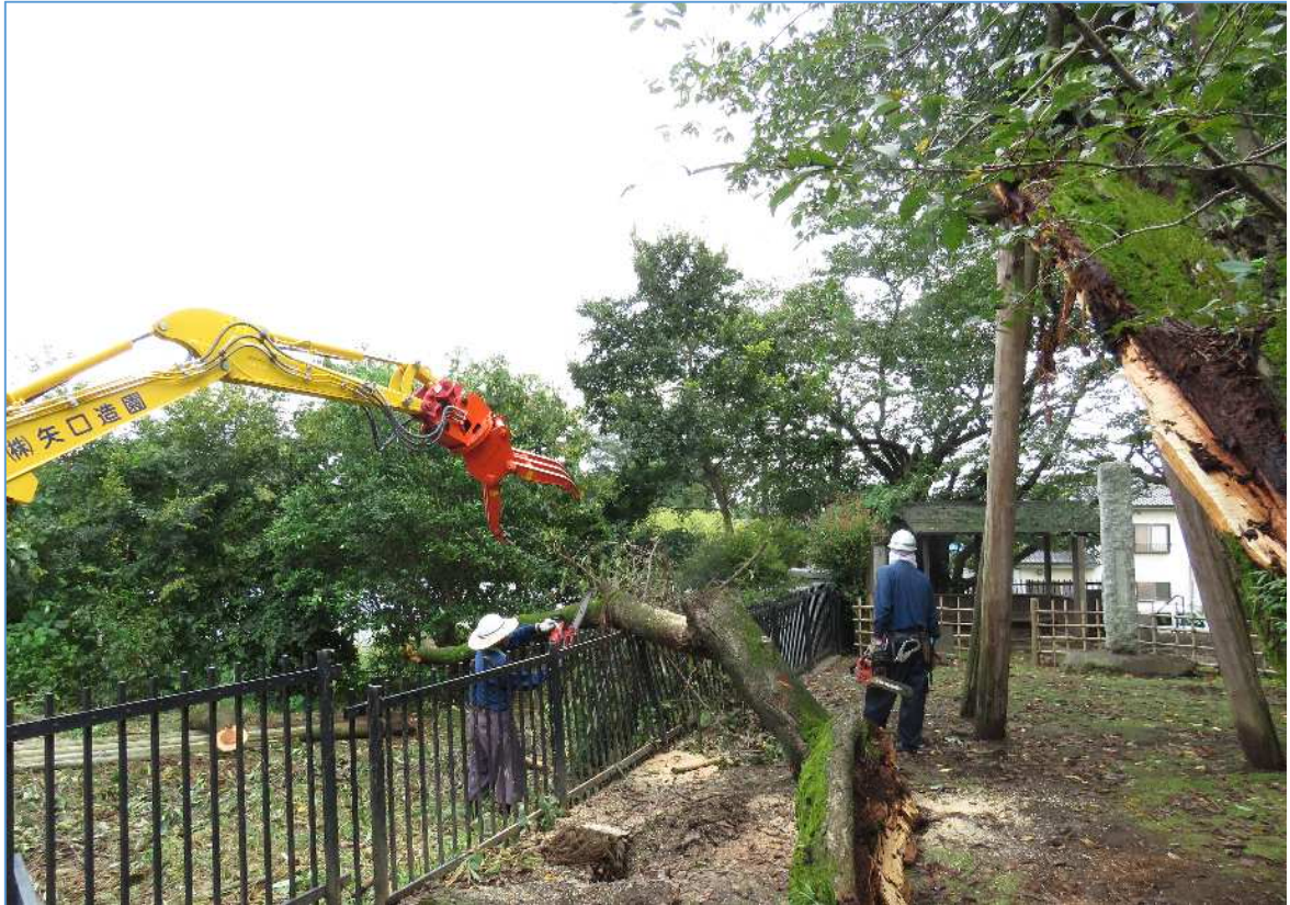
き損枝の撤去作業①
