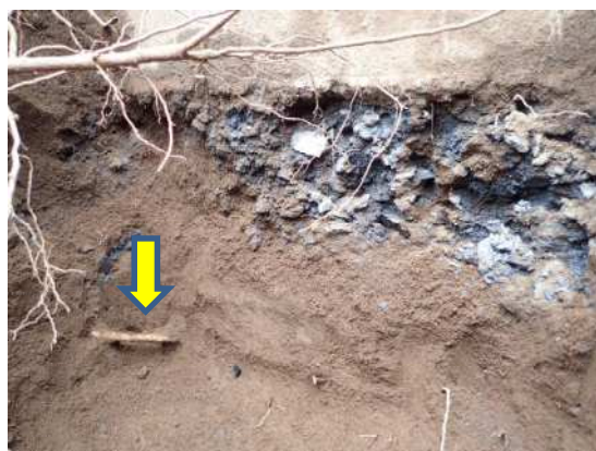
ブロック基礎下における根系の北側への伸長状況（南西から撮影）
