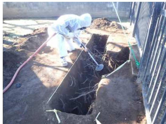
エアースコップによる掘削状況
