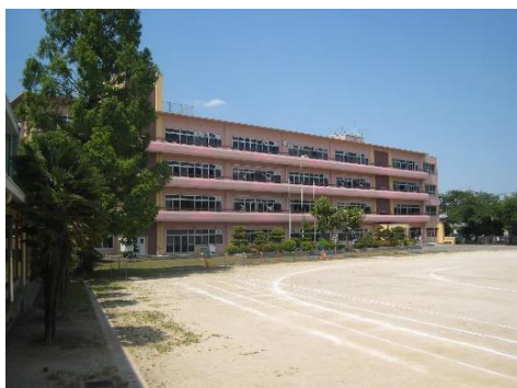
校舎棟A棟
