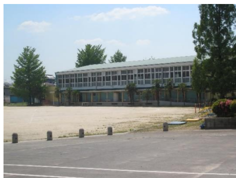
屋内運動場外観
