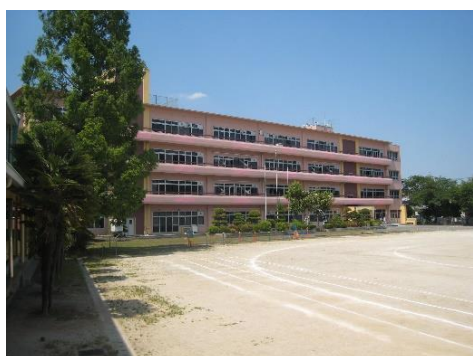
校舎棟 A 棟
