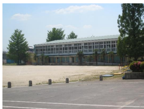
屋内運動場外観
