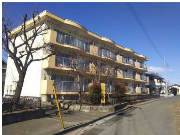
市営台原住宅
