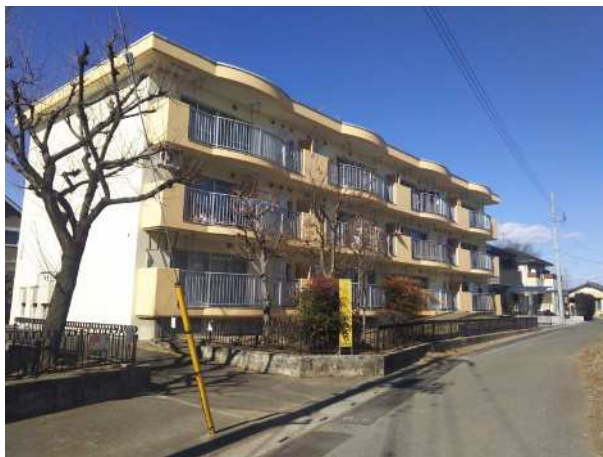
市営台原住宅
