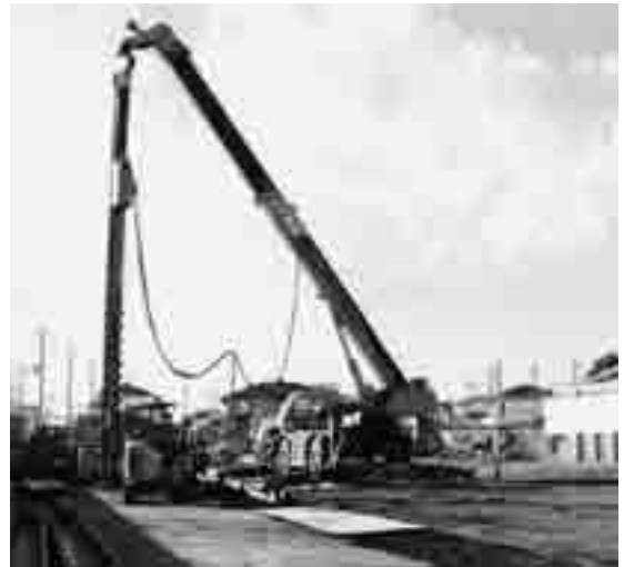
基礎工事の様子
