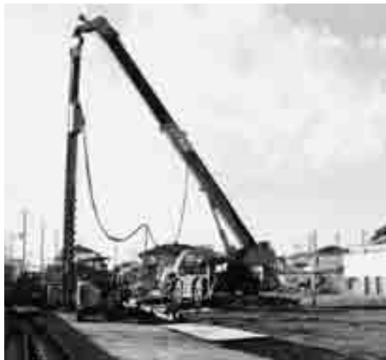
基礎工事の様子
