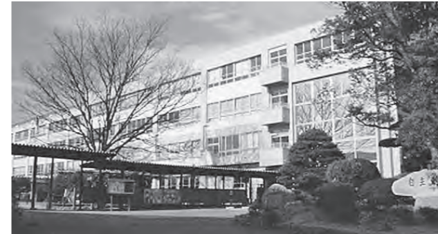
大規模改修による長寿命化 校舎外部
