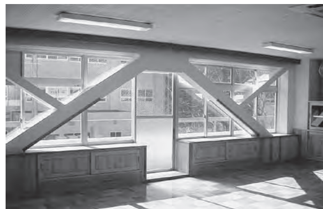
耐震補強した校舎内部の様子
