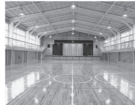
改修を行った体育館内部
