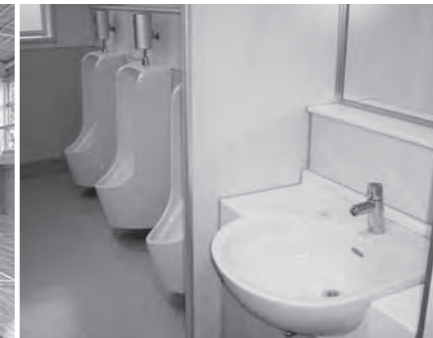
改修を行ったトイレ
