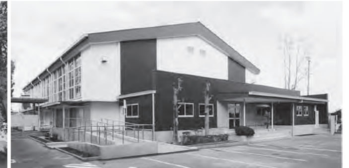
大規模改修による長寿命化 体育館外部
