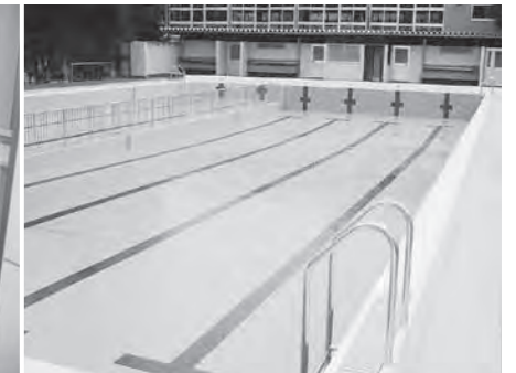
改修を行ったプール
