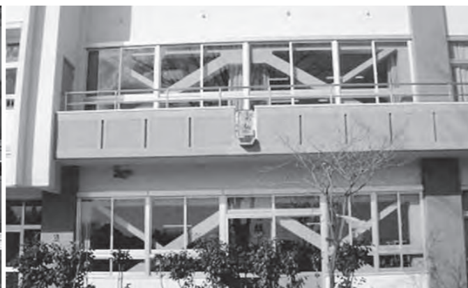
耐震補強した校舎外部の様子
