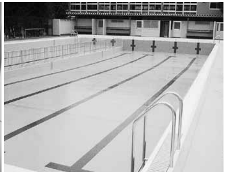
改修を行ったプール
