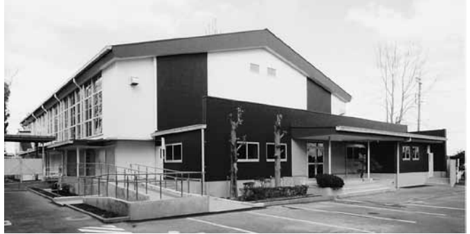
大規模改修による長寿命化 体育館外部
