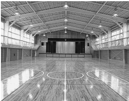
改修を行った体育館内部
