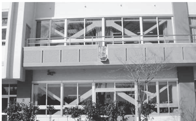
耐震補強した校舎外部の様子
