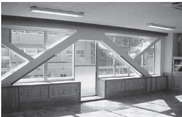
耐震補強した校舎内部の様子
