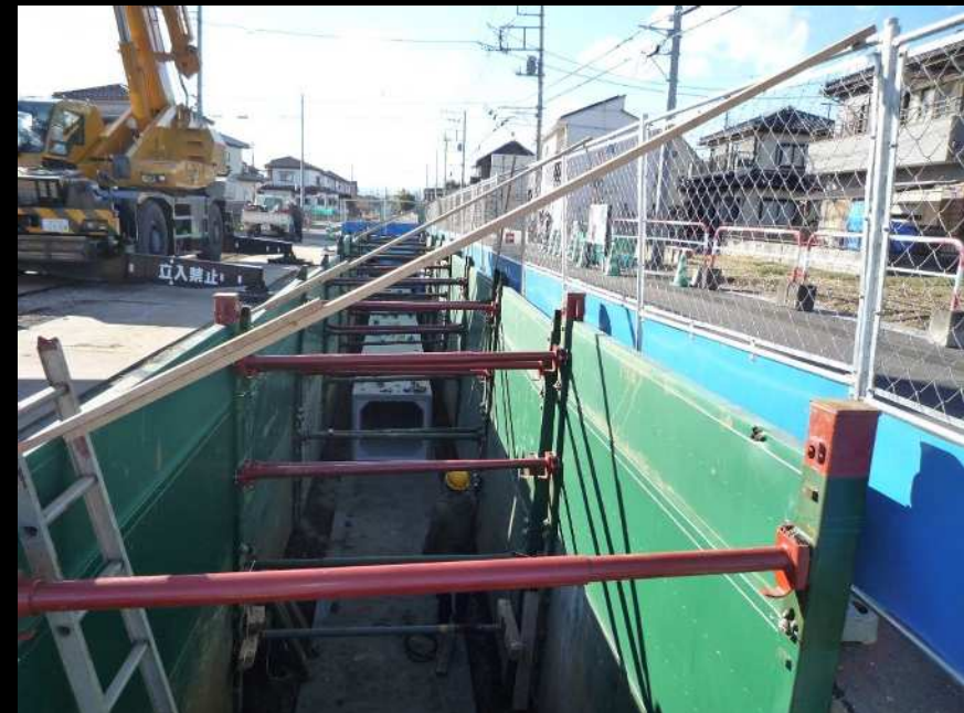
令和5年度雨水函渠埋設工事の様子(久保大通線)
